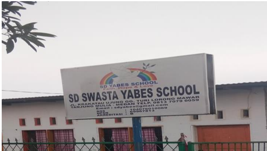
Gambar 1. Lokasi Pengabdian dan Bangunan Sekolah
